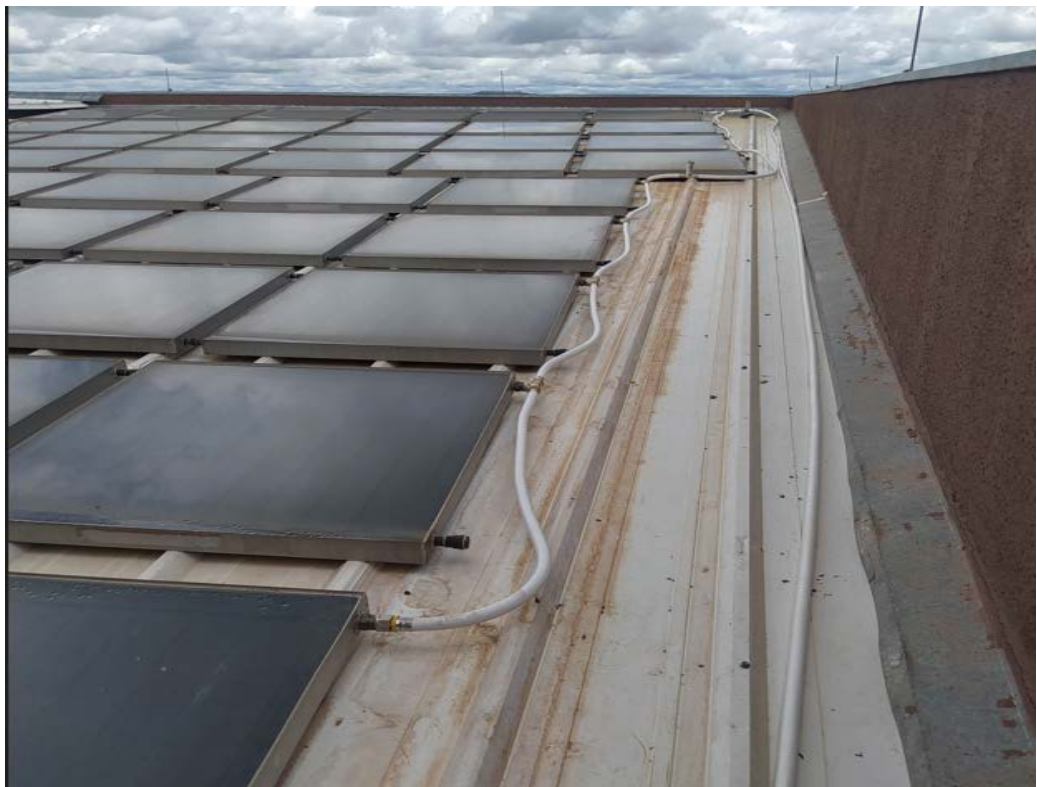
Figura 4: Nova tubulação em PEX, instalada.
