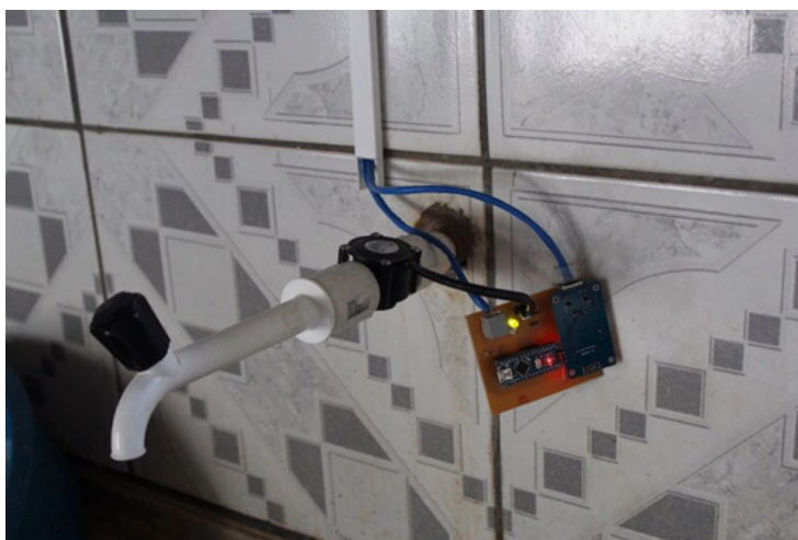
Figura 1: Sensor de fluxo instalado em torneira.
