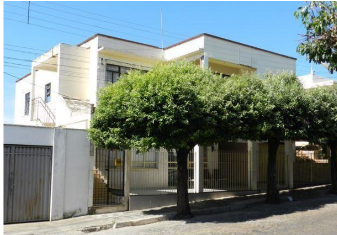
Figura 14: Residência 2. Uso de platibanda e esquadrias em ferro com fechamento de vidro.
