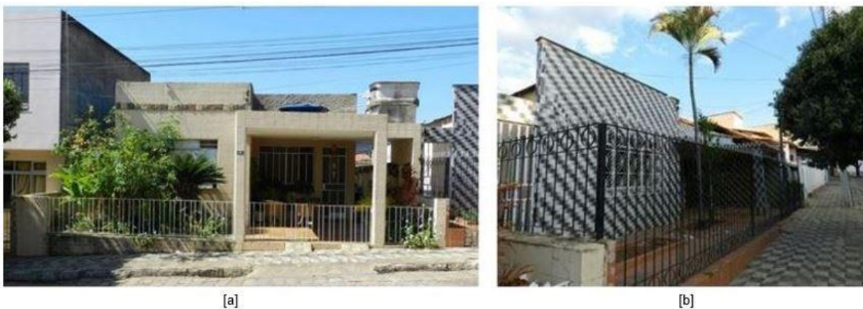
Figura 16: Residência 4 [a] fachada com mosaico de pedras na platibanda; Residência 5 [b] uso de azulejos na fachada
