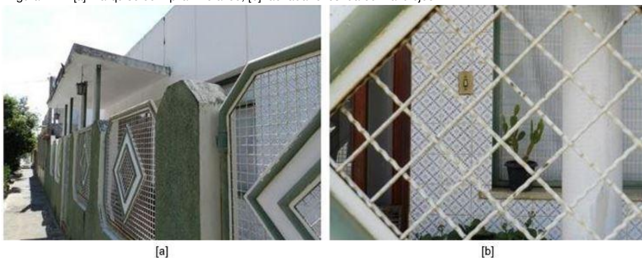
Figura 17.1: [a] Marquise com pilar metálico; [b] fachada revestida com azulejos.
