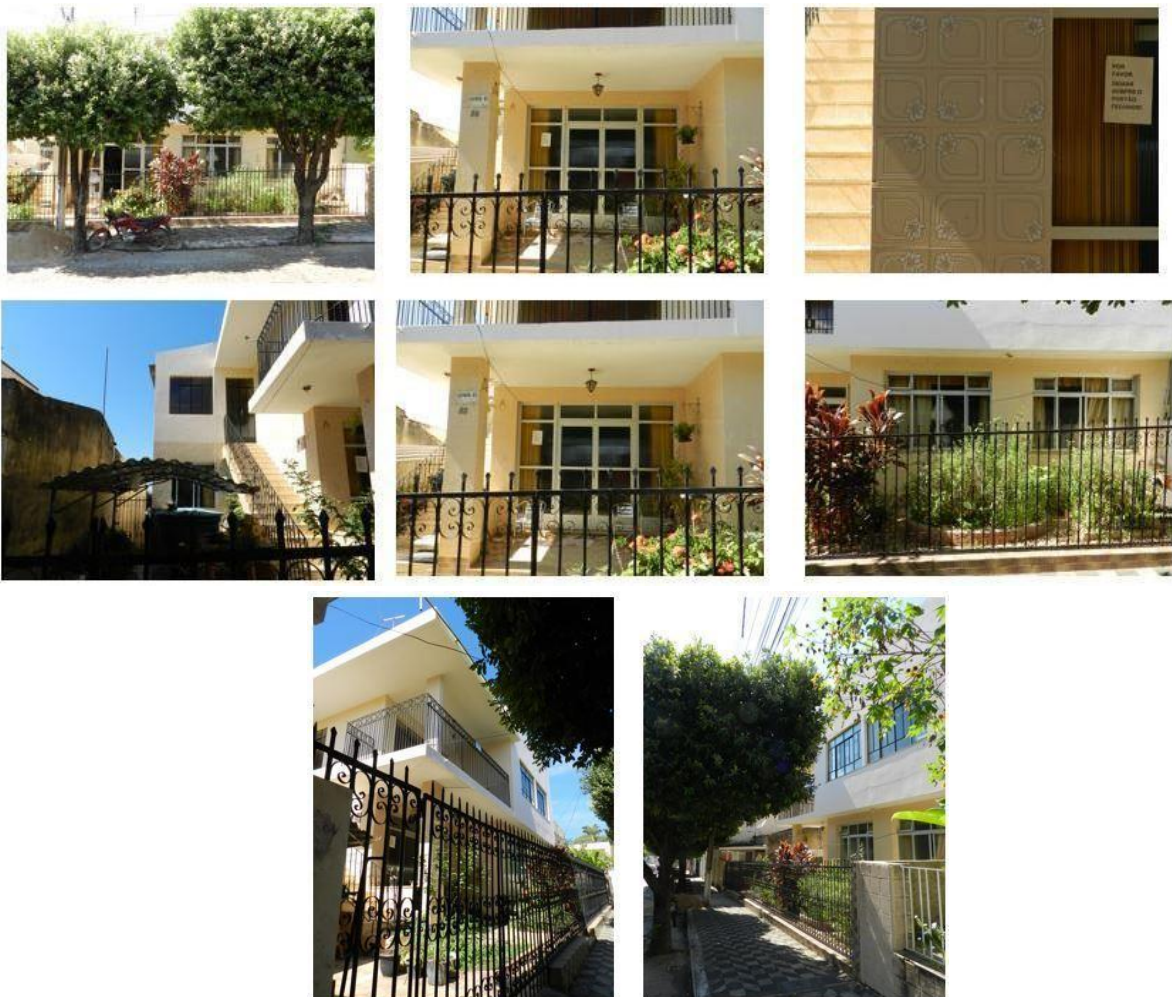
Figura 15.1: Laje plana da varanda com balanço discreto confere leveza, suavizando a imposição do caixote no corpo principal do edifício.
