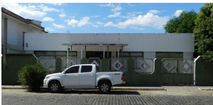
Figura 17: Residência 6, casa de Dona Idalina. Destaque para a platibanda modulada em seções retangulares idênticas.
