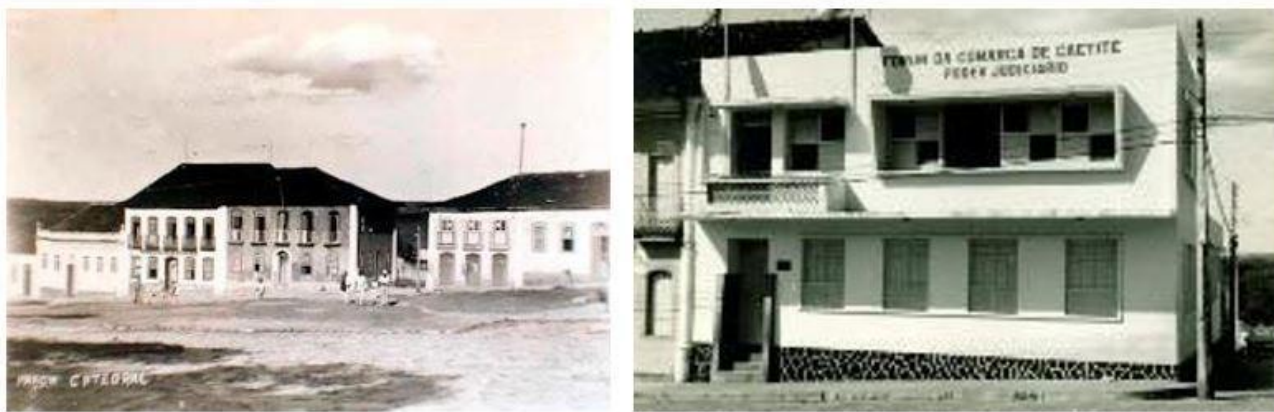
Figura 4: [a] Sobrado (segundo da direita para esquerda), onde após reforma/demolição(?) abrigou o primeiro Fórum da cidade; [b] Primeiro Fórum de Caetité (imagem com data não obtida, mas à época da primeira intervenção).
