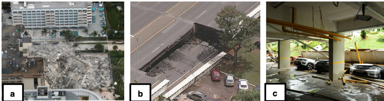
Figura 1: Sinistros na construção civil.
