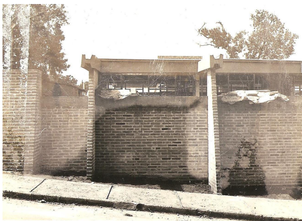
Figura 4: Foto da Construção da Residência Maffei
