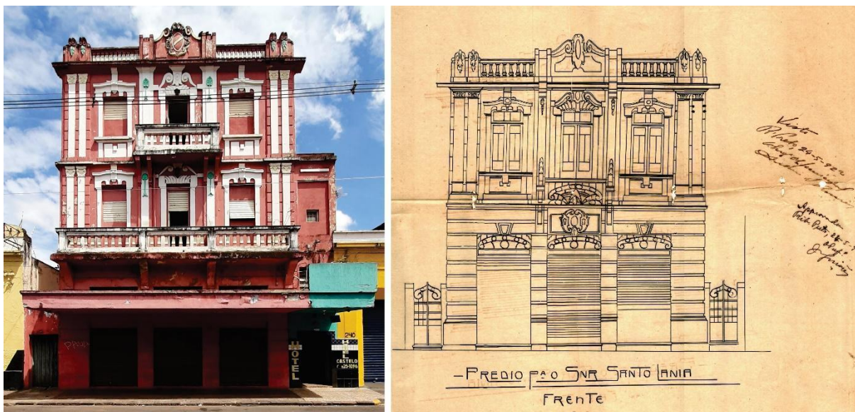
Figura 2: Edificação à Rua José Bonifácio e detalhe da fachada (Processo n. 95 de 1922)
