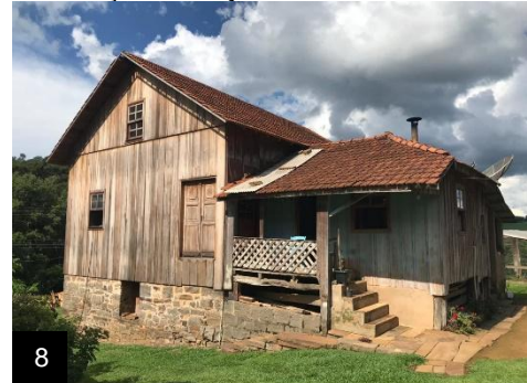
Figura 8 – Atual situação da casa, após as intervenções de layout.
