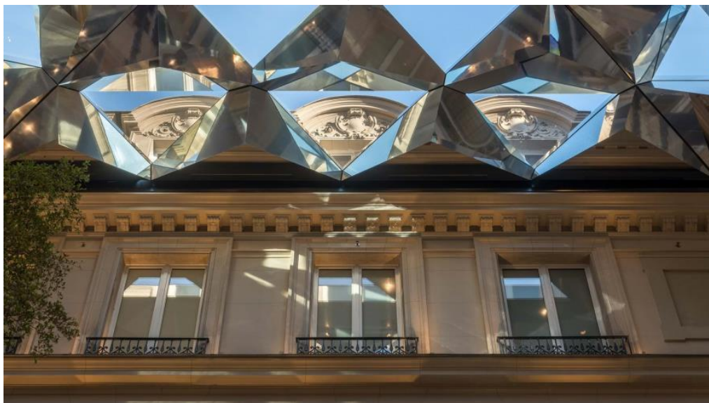
Figura 15: Painéis fotovoltaicos da Apple Champs-Élysées.
