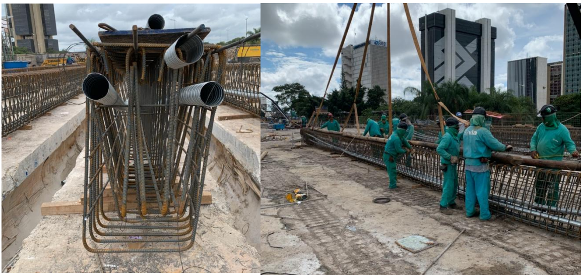
Figura 25 - 26: Armaduras das longarinas de concreto
