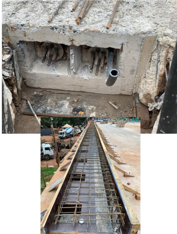
Figura 27 - 28: Nova armadura de protensão e reconstituição das galerias de águas pluviais
