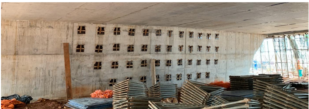
Figura 24: Novo pilar após projeto de Retrofit
