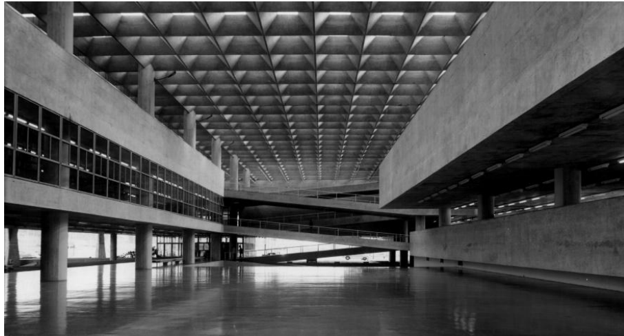
Figura 4: Vista interna do vão central (Salão Caramelo) do edifício Vilanova Artigas.
