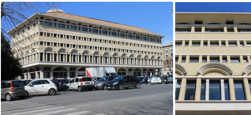
Figuras 2 e 3: Sede do Partido Democracia Cristã (1955-58), Roma. Fonte: Leandro de Cruz e Souza.
