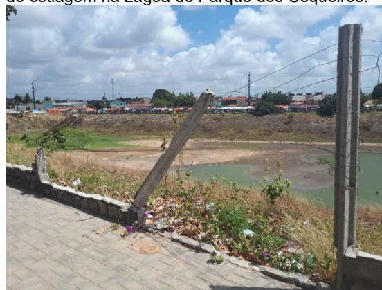
Figura 24: Existência de água servida no período de estiagem na Lagoa de Parque dos Coqueiros.
