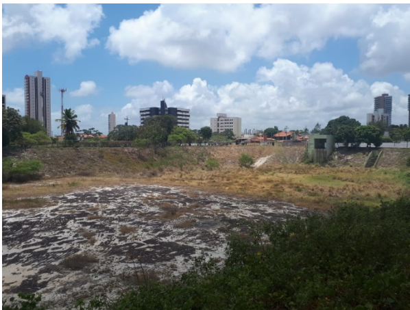
Figura 17: Vista do Reservatório de Detenção 01.
