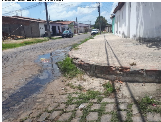
Figura 23: Presença de esgoto a céu aberto nas ruas da Zona Norte.
