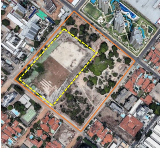
Figura 15: Vista de Topo do Parque de Capim Macio e do Reservatório de Detenção 01.
