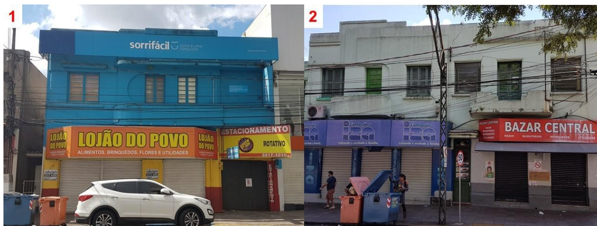
Figura 7: Edificações nº 1 e nº 2 que apresentaram alterações significativas provenientes da atividade publicitária.
