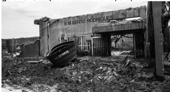
Figura 15: Situação da escola municipal após o acidente.
