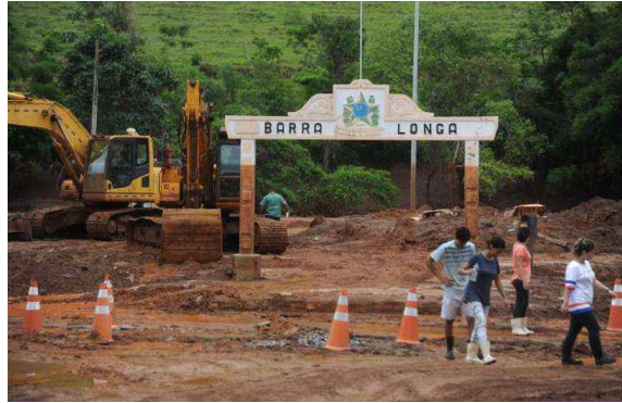
Fonte: Leandro Couri, Estádio de Minas (EM)
