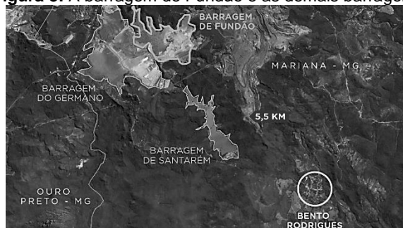
Figura 3: A barragem de Fundão e as demais barragens.
