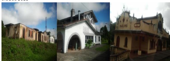
Figura 2: Patrimônio edificado da Ferrovia Curitiba – Morretes
