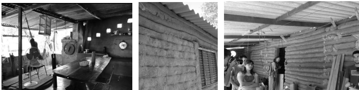
Figura 2(a,b,c): Habitação construída em hiperadobe no assentamento Colônia I.
