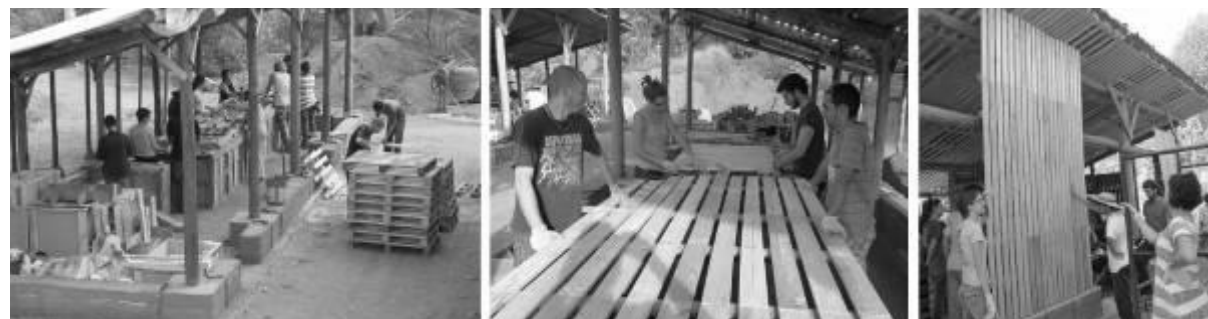
Figura 10: Realização e fixação dos painéis de parede produzidos a partir dos paletes descartados. Estes, foram desmontados, classificados, cortados e remontados sob medida. A mesa de produção foi adaptada e os grupos refletiam e construíam os painéis através de suas etapas produtivas.
