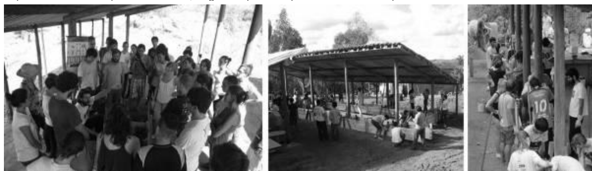
Figura 8: A base da casa foi realizada de maneira semelhante à fundação. A terra do lote foi estabilizada com cimento e apiloada dentro de fôrmas de madeira em camadas sucessivas. Primeiramente, foram realizadas as taipas em torno dos pilares da casa, seguidas pelas taipas das bases das paredes.
