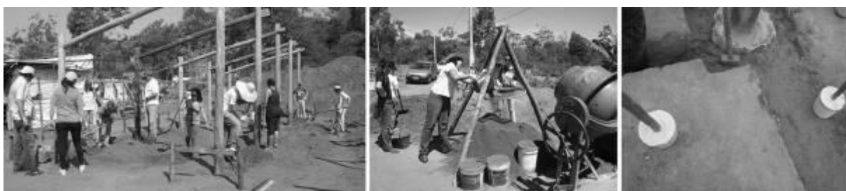
Figura 6: Através da organização coletiva os grupos realizaram os trabalhos referente à escavação e preparação das fundações da casa a partir da técnica da taipa de pilão. A terra local foi estabilizada com cimento e apiloada em camadas sucessivas dentro das fundações.
