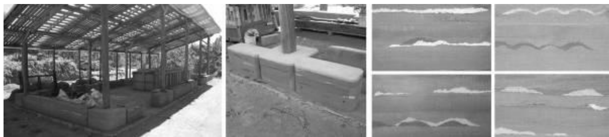
Figura 9: Base das paredes em taipa de pilão. Durante a compactação foram colocadas terras de cores diferentes que criavam variações na taipa de pilão. Também foram realizados ângulos chanfrados para limitar o desgaste dos cantos da taipa e encaixes tipo macho-fêmea na união entre as bases de taipa.
