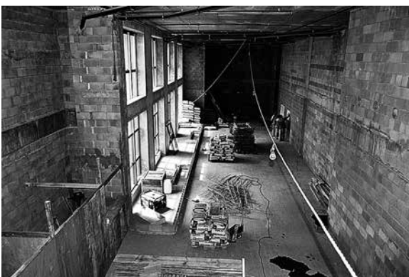
Figura 02: Local antes da instalação dos mezaninos
