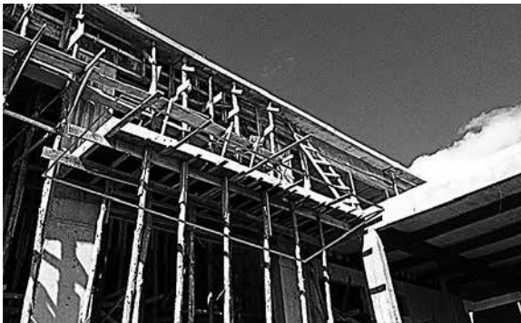
Figura 26: Marquise na fachada frontal.
