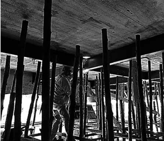
Figura 30: Vigas metálicas sendo soldadas em obra.
