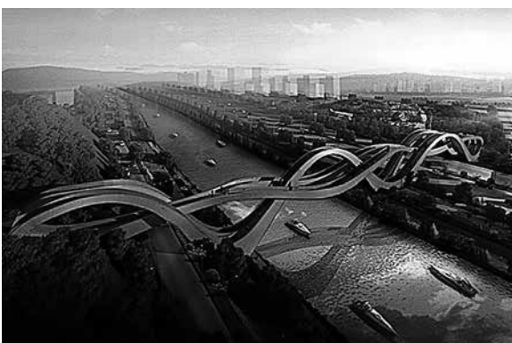
Figura 6: Ponte para pedestres
