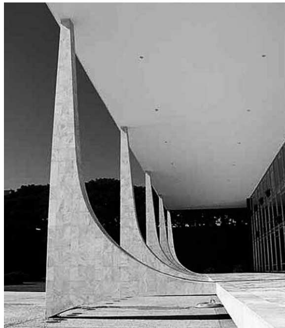
Figura 7: Nos pilares do Supremo Tribunal Federal, as curvaturas estão voltadas para a lateral do edifício.
