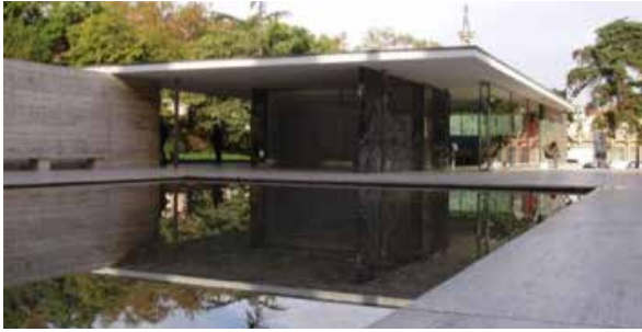
Figura 2: Reconstrução do Pavilhão de Barcelona – Projeto original de Mies Van der Rohe
