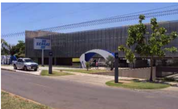
Figura 9: edifício Sede do Sebrae Nacional
