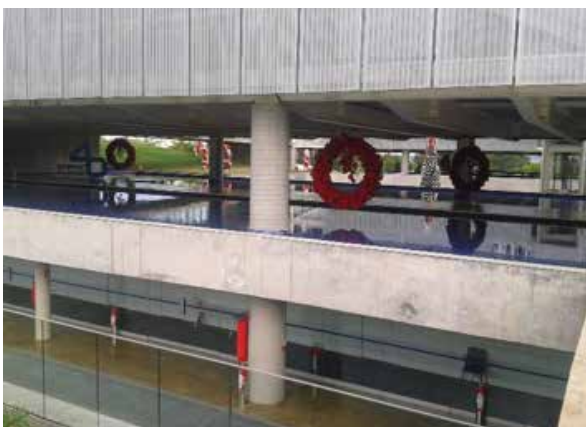
Figura 10: edifício Sede do Sebrae Nacional espelho d'água
