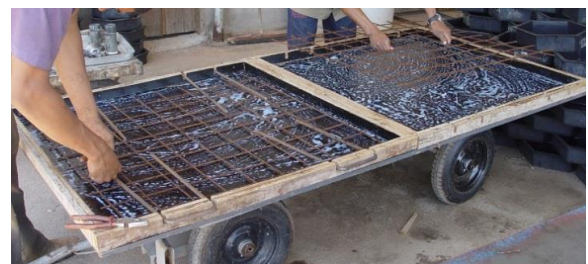
Figura 3: Ferragem das placas de contrapiso.
