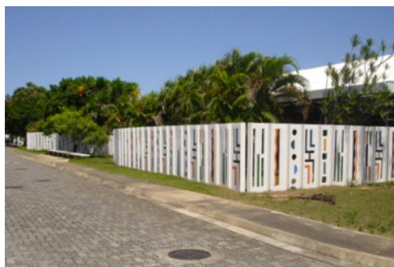
Figura 9: Fachada da sala de espera
