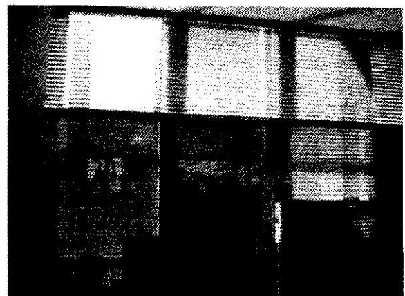
Figura 13: Sala original com persianas em tecido (esquerda) e sala protótipo com modificações propostas (persianas aluminizadas perfuradas, prateleira de luz e película de controle solar).
