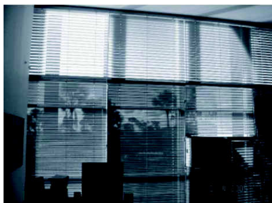
Figura 12: Sala protótipo com modificações propostas (persianas de alumínio perfuradas, prateleira de luz e película de controle solar) (Fonte: GRILLO, 2005)
