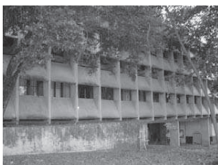
Fachada Nordeste com brises mistos
