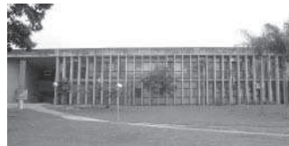
Vista externa do edifício (fachada sul)
