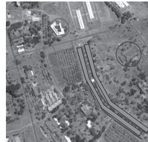
Vista aérea do edifício Fonte: Google
