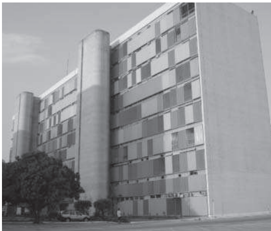
Figura 10 - Fachada oeste (288°): brise-soleil vertical.
