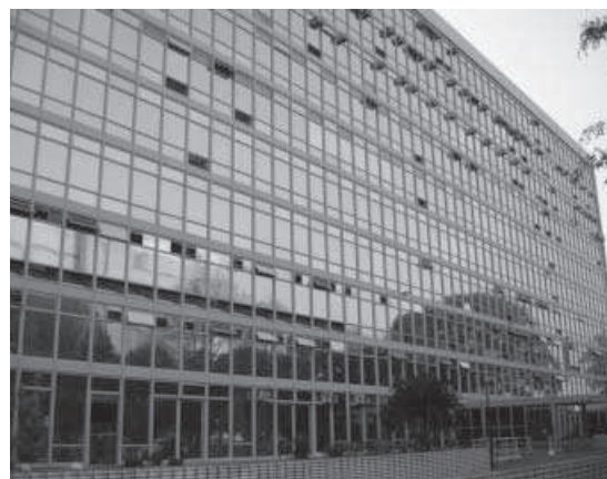
Figura 9 - Fachada leste (108°): película espelhada. n
