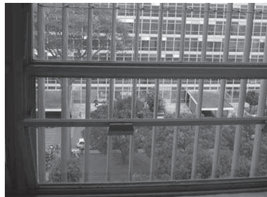
Figura 13- Acesso aos brises pela janela.
