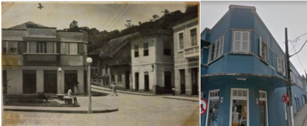
Figura 5 - Detalhes do casarão 6.04
