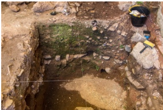
Figura 3 – Área escavada para a instalação do elevador em 2016.
