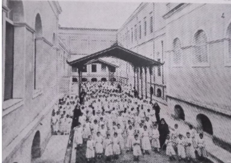
Figura 04: Pavilhões do pátio do recreio do Instituto
