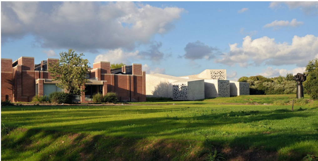
Fig.2. Fachada do Lille Métropole Musée d'art moderne, d'art contemporain et d'art brut. Fonte: Foto do autor
