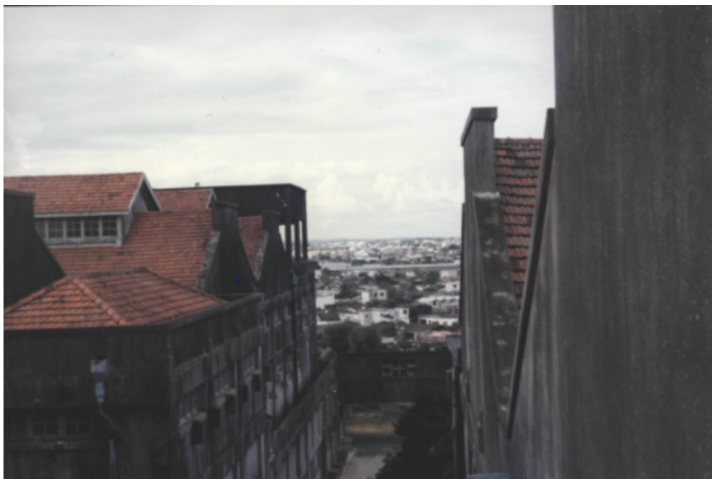
Figura 1 – Fotografia de dentro do prédio das câmaras frigoríficas.
