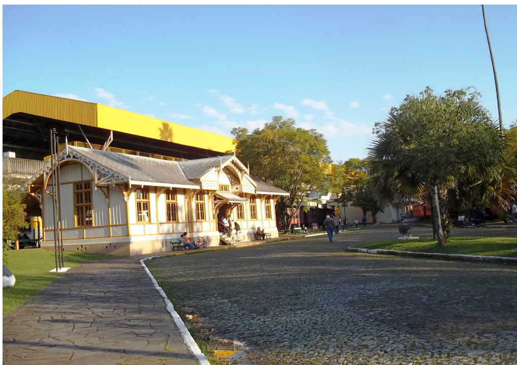
Figura 1: Foto da fachada do Museu do Trem de São Leopoldo/RS.
