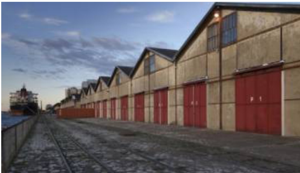
Imagem 3 - Armazéns do Cais do Porto de Porto Alegre (vista parcial). Fonte: Aautora.
