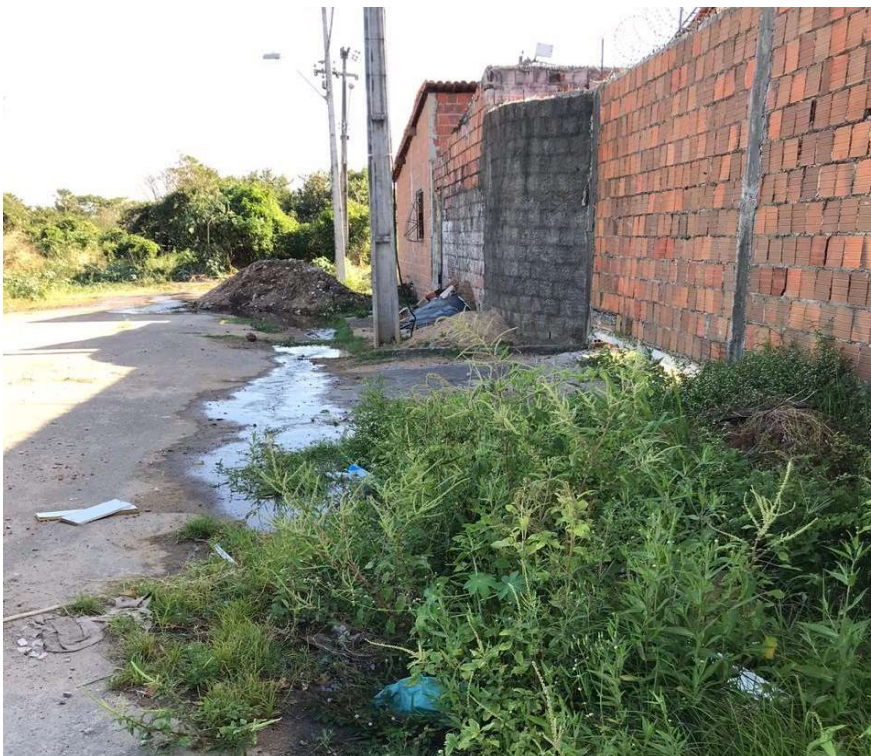
Figura 6: Situação de esgoto a céu aberto na comunidade do Marrocos (Grande Bom Jardim). Fonte: acervo pessoal, 2020.
