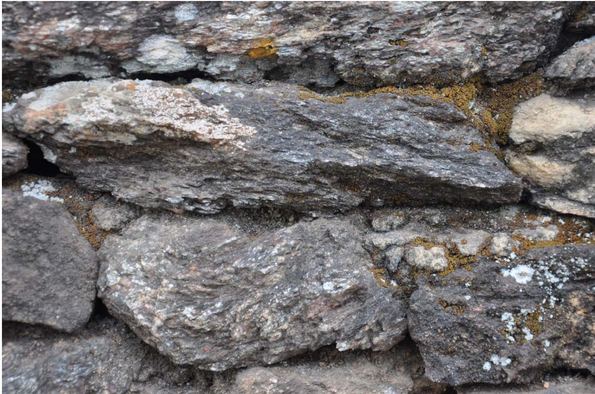
Foto: Prof. Rafael Sanzio dos Anjos. Detalhe da parede de pedra tradicional. Pirenópolis – Goiás, 2015.
