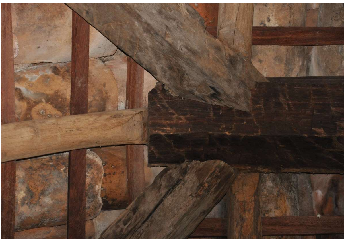
Foto: Prof. Rafael Sanzio dos Anjos. Detalhe da cumieira de madeira de um telhado tradicional. Pirenópolis – Goiás, 2015.
