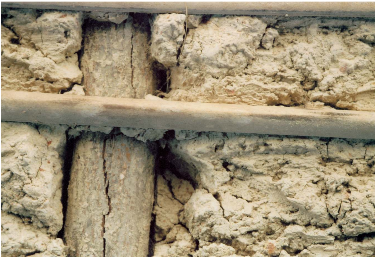
Foto: Prof. Rafael Sanzio dos Anjos. Detalhe parede de Supapo (Pau a pique) no Recôncavo da Bahia. Cahoeira – Bahia. 2017.
