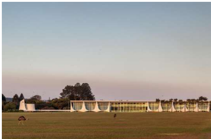
Figura 7 - Fachada frontal do Palácio do Alvorada. Fonte: FRACALLOSSI, 2015, online.
