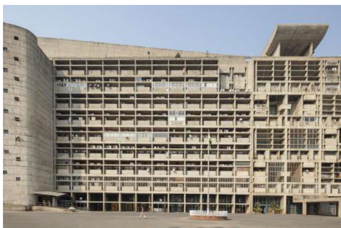
Figura 10 - Fachada do Secretariado. Fonte: HOLANDA, 2012, online.
