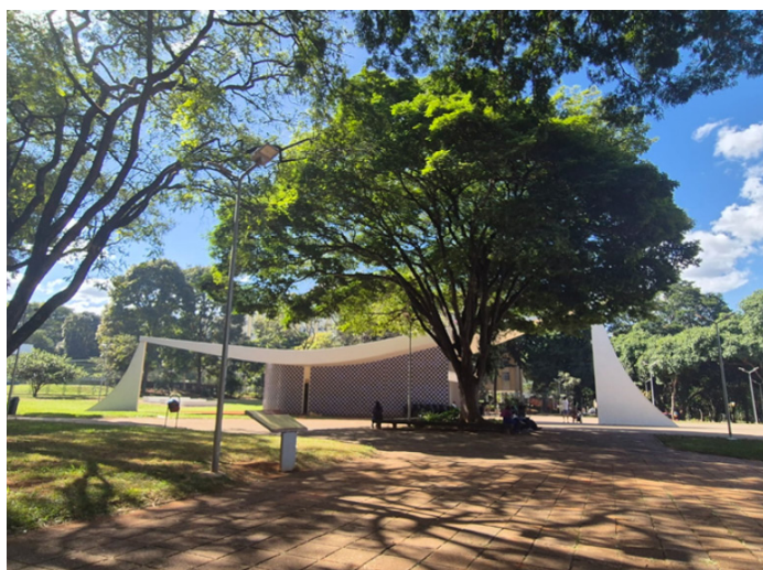
Fig. 12 – Vista da Igrejinha. Foto Carolina Borges
