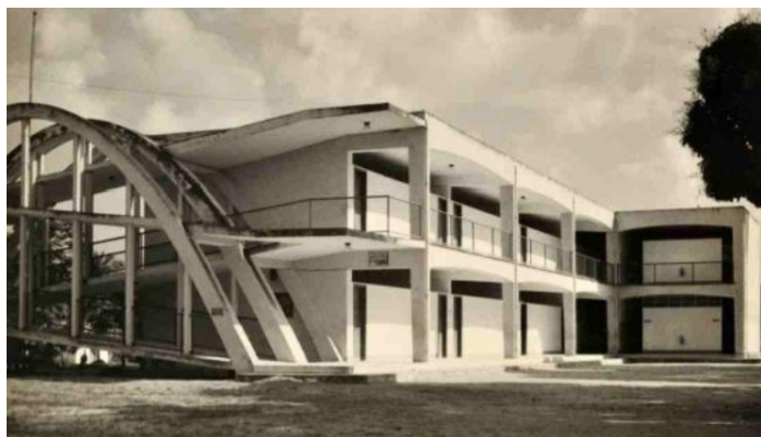
Figura 3 – Escola Rural Alberto Torres Recife (PE), projeto do Arq. Luiz Nunes, construído em 1935-36.
