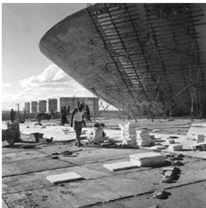
Figura 14: Construção da Cúpula da Câmara dos Deputados, 1958
