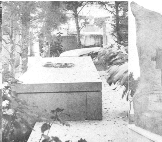
FIGURA 22: Túmulo de granito apicoado. Cemitério Municipal de Petrópolis, Rio de Janeiro. FONTE: VALLADARES, 1972, p. 627.
