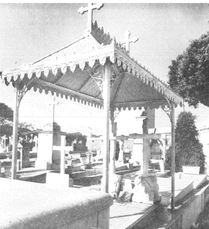
FIGURA 16: Túmulo com cobertura de metal (zinco) estampado. Cemitério S. Francisco Xavier, Rio de Janeiro. FONTE: VALLADARES, 1972, p. 1073.
