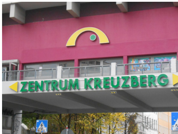
Figura 2 – Detalhe do pórtico
