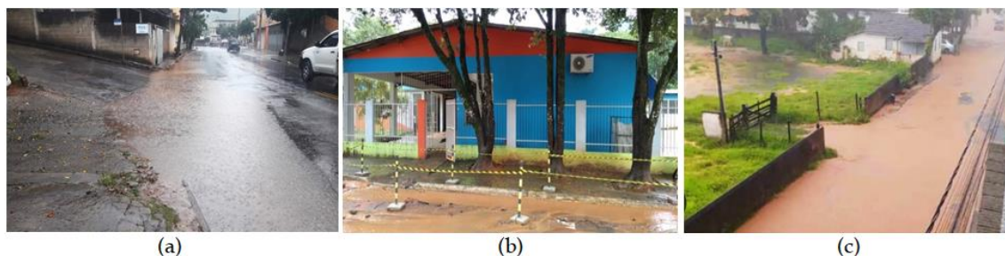
Figura 3: Impacto das chuvas de janeiro de 2020 na BHCA (Rua João Sasso): enxurrada em pavimento (a); escola interditada (b) e trecho inundado (c). Fonte: PMCI, 2020.
