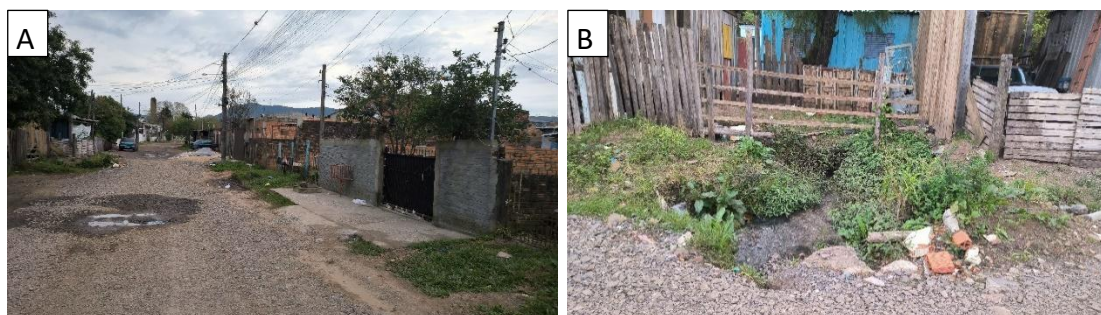
Figura 5. Travessa da Chaminé, onde ocorrem alagamentos associados a problemas de drenagem pluvial (A) e rua E, onde a canalização do arroio de forma ineficiente e praticamente entulhada de sedimentos também causa alagamentos (B).
