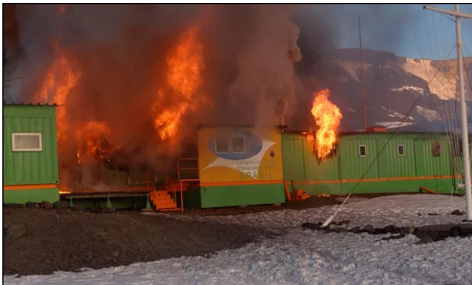
Figura 1. Incêndio na Estação Antártica Comandante Ferraz em 2012. Fonte: Poggio (2012).
