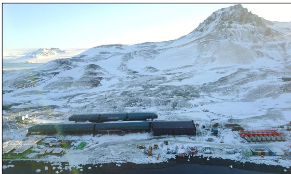
Figura 2. Instalações da Estação Antártica Comandante Ferraz. Fonte: Brasil (2023b).
