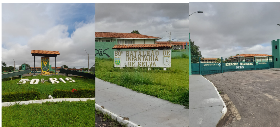
Figuras 5a, 5b e 5c. Diferentes ângulos da fachada do 50 BIS
