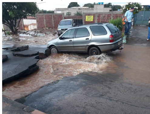
Figura 08: Asfalto arrancado do solo devido à forte enxurrada no dia 13/04/2019, na cidade de Arniqueira, no Distrito Federal.
