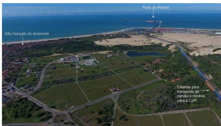
Figura 9 – Vista aérea do Porto de Pecém, São Gonçalo do Amarante e Estreiras que alimentam à CSP. Fonte: Porto de Pecém
